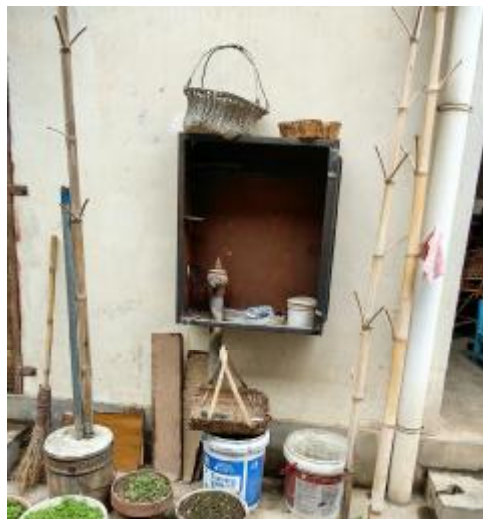
图 3-6 医院宿舍内消火栓设施缺失
